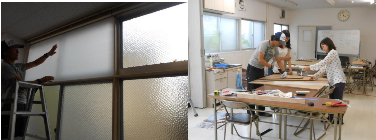
手作り内窓を設置講習会 京丹後市 (H26/10/11)
