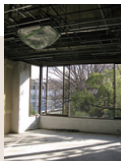
写真：工事中、スケルトンにした元閲覧室（部分）
