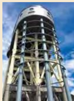
フィールドワークで黒潮町の津波避難タワーに行きました
